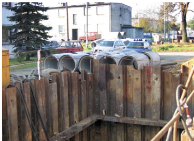
Fot. 3. W tle rury żelbetowe przeciskowe DN 800 mm
