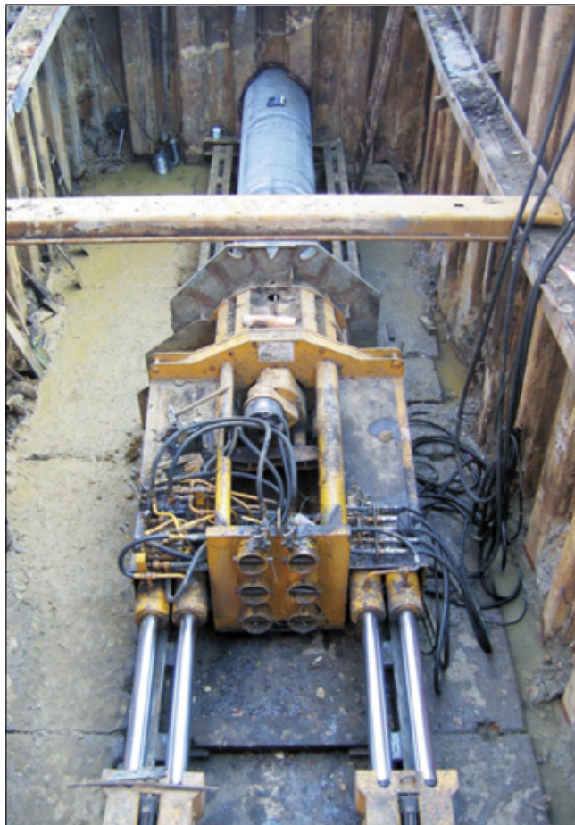
Fot. 2. Komora startowa
