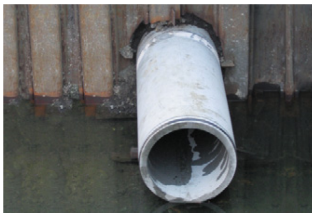
Fot. 4. Rura w komorze odbiorczej
