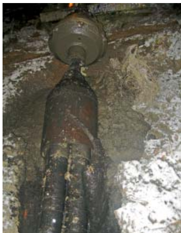
Fot. 4. Finał przewiertu 4 x 160 mm
