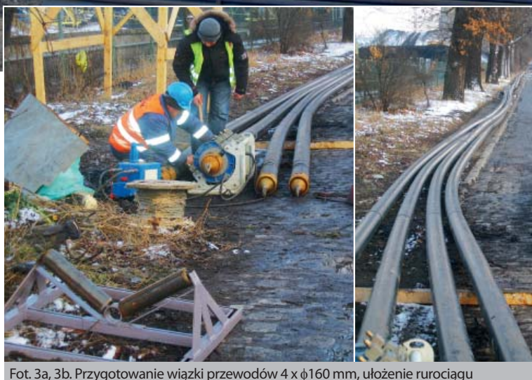
Fot. 3a, 3b. Przygotowanie wiązki przewodów 4 x \phi 160 mm, ułożenie rurociągu
