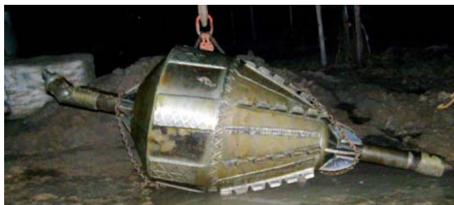
Fot. 7a, 7b. Finał przeciągania przewodu \phi 800 mm, stacja nadawcza i odbiorcza
