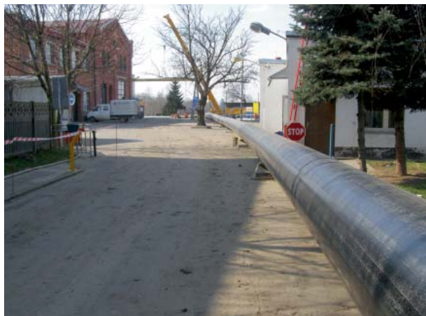
Fot. 5. Wciąganie rury polietylenowej 800 mm na rolkach
