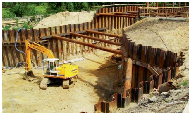
Fot. 2. Tymczasowe zabezpieczenie wykopu dla budynku krat i piaskownika
