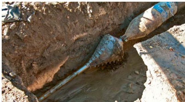
Fot. 2. | Rozwiertak wraz ze złączem obrotowym i przymocowaną do niego rurą HD PE gotową do wciągnięcia
