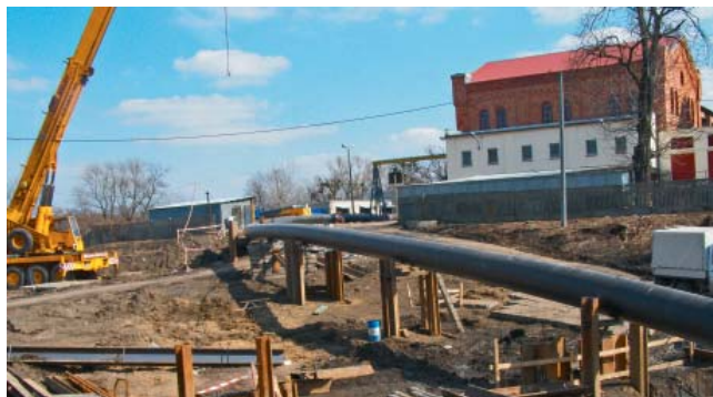
Fot. 3. | Płyty stalowe zmniejszające tarcie rury instalowanej w gruncie w technologii HDD
