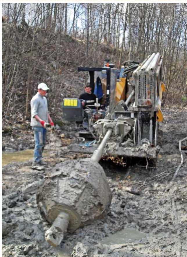
Fot. 2. | Wiertnica Vermeer wraz z rozwiertakiem stalowym
