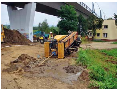
Fot. 4. | Wykonywanie przewiertu pilotowego żerdzią \phi 140 mm
