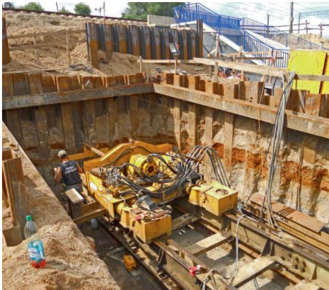
Fot. 3. | Maszyna WP 80/100 firmy Wamet podczas wykonywania przewiertu żerdzią \phi 114 mm
