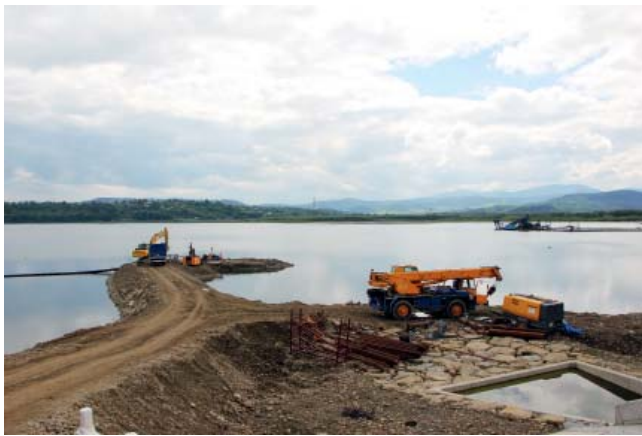
Fot. 4. „Wyspa technologiczna” wraz z groblą dojazdową
