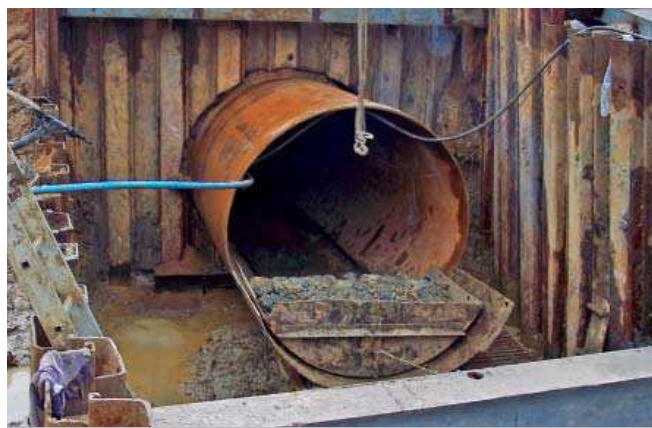
Fot. 4. Komora nadawcza w trakcie wykonywania przewiertu
