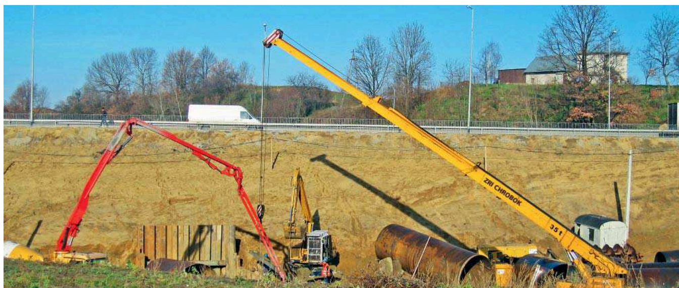
Fot. 5. Plac budowy w trakcie realizacji
