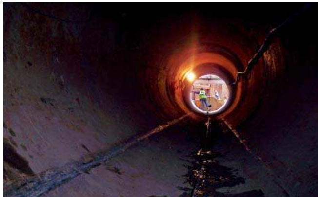
Fot. 3. Wnętrze rury przewiertowej Ø 2820 mm
