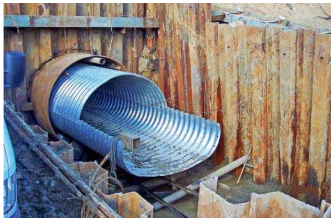
Fot. 2. Zamontowana rura przewodowa TUBOSIDER
