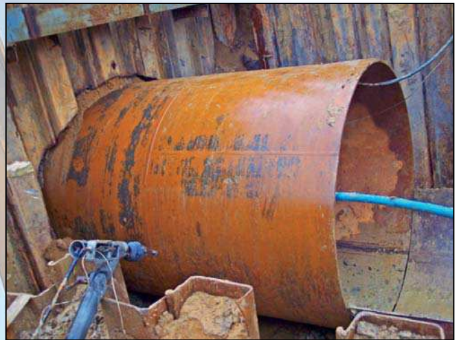
Fot. 1. Komora nadawcza wraz z rurą przewiertową
