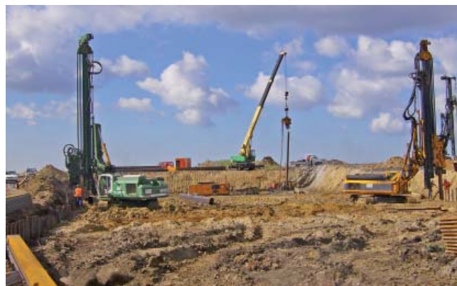
Fot. 1. Zespoły robocze podczas pogrążania grodzic – zbiornik retencyjny ZR1
