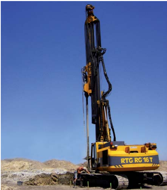
Fot. 3. Wiertnica podczas formowania kolumn DSM
