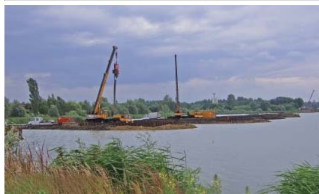
Fot. 5. Próbną kolumna jet-grouting \phi 800 mm Belk
