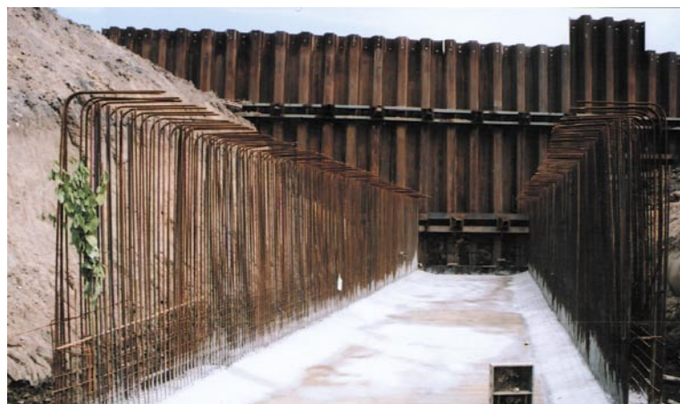
Fot. 5. Obiekt nr 3/IV
