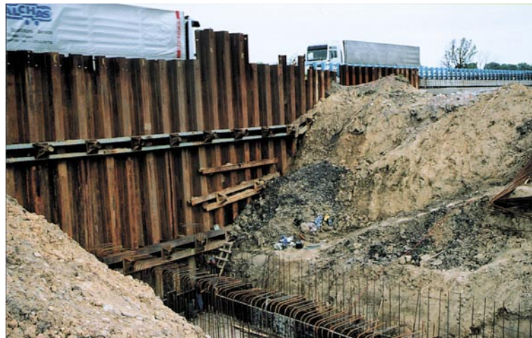
Fot. 4. Dwa rzędy kotew gruntowych. Za ścianką w pasie rozdziału prowadzony jest ruch samochodowy
