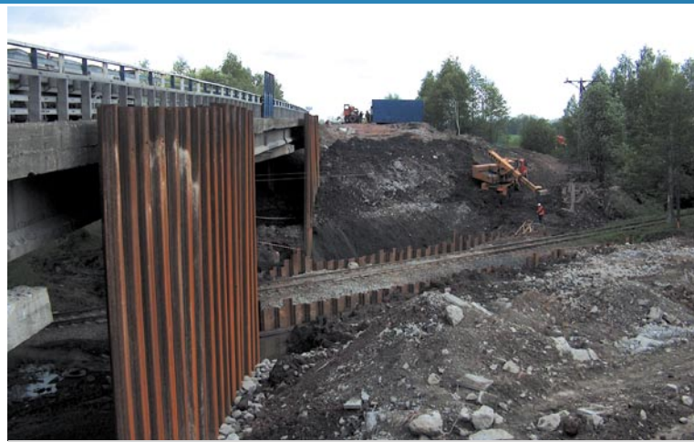
Fot. 3. Obiekt nr 4/IV
