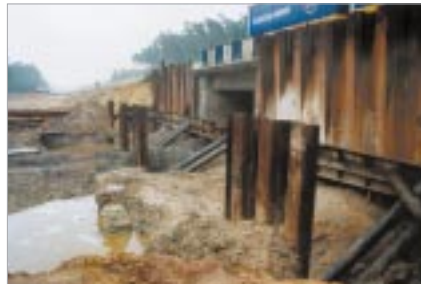
Autostrada A4 – Kontrakt nr 7 – czerwiec 2002.
