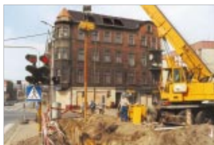
Drogowa Trasa Średnicowa w Katowicach - październik 2001.
