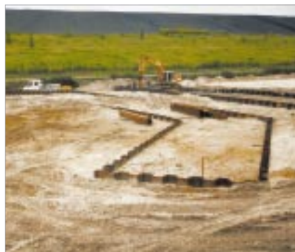
Autostrada A4 - Kontrakt nr 8 - sierpień 2002
