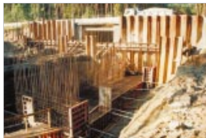
Autostrada A4 – Kontrakt nr 7 – czerwiec 2002.
