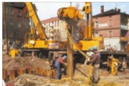
Drogowa Trasa Średnicowa w Katowicach - październik 2001.
