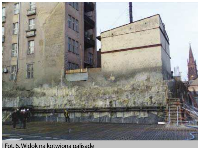
Fot. 6. Widok na kotwioną palisadę
