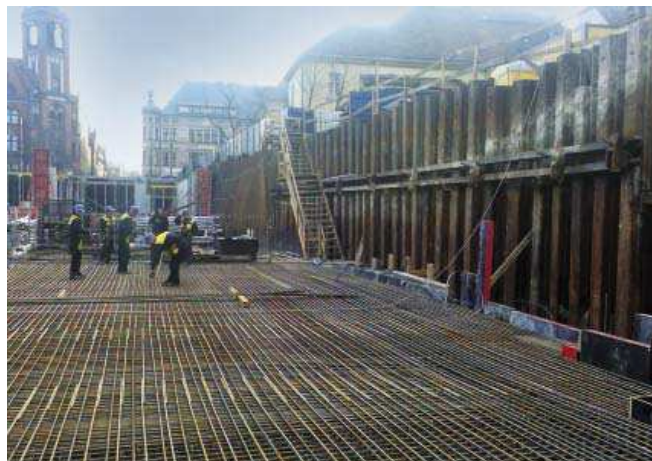
Fot. 3. Prace zbrojarskie w umocnionym wykopie
