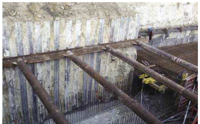
Fot. 1. Odslonięte kolumny jet-grouting
