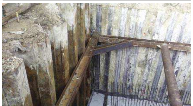
Fot. 2. Zabezpieczenie dla komory ciepłowniczej w rejonie istniejącego budynku
