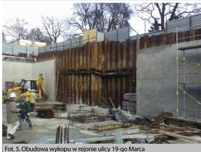
Fot. 5. Obudowa wykopu w rejonie ulicy 19-go Marca
