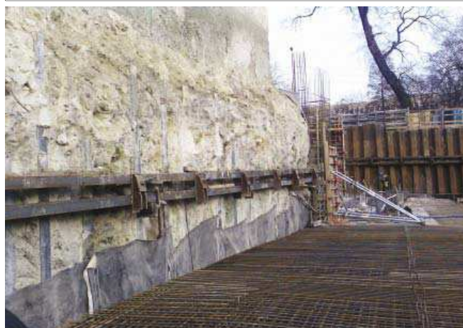
Fot. 4. Palisada jet-grouting przy istniejących budynkach
