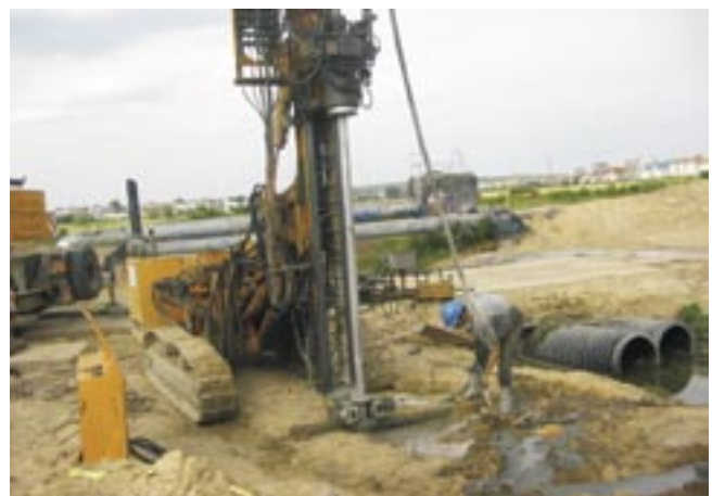
Fot. 6. Formowanie kolumny w gruncie
