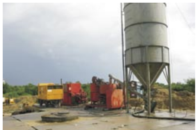
Fot. 5. Ciąg technologiczny do wykonywania iniekcji jet-grouting
