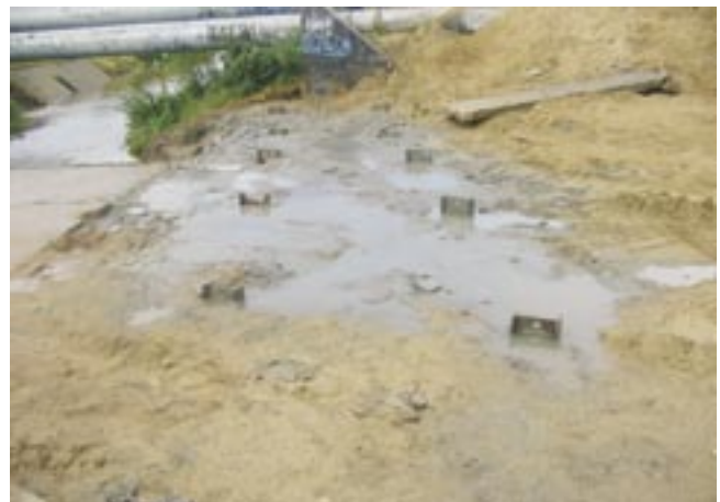
Fot. 4. Wykonane kolumny z wystawionym zbrojeniem z dwuteownika IPE240
