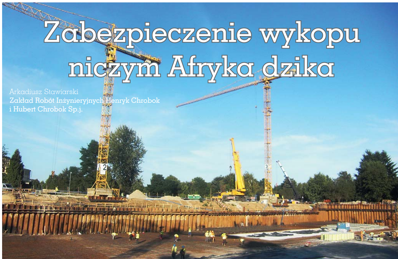
Fot. 1. Układanie zbrojenia płyty fundamentowej w wykopie zabezpieczonym ścianką z grodziec
