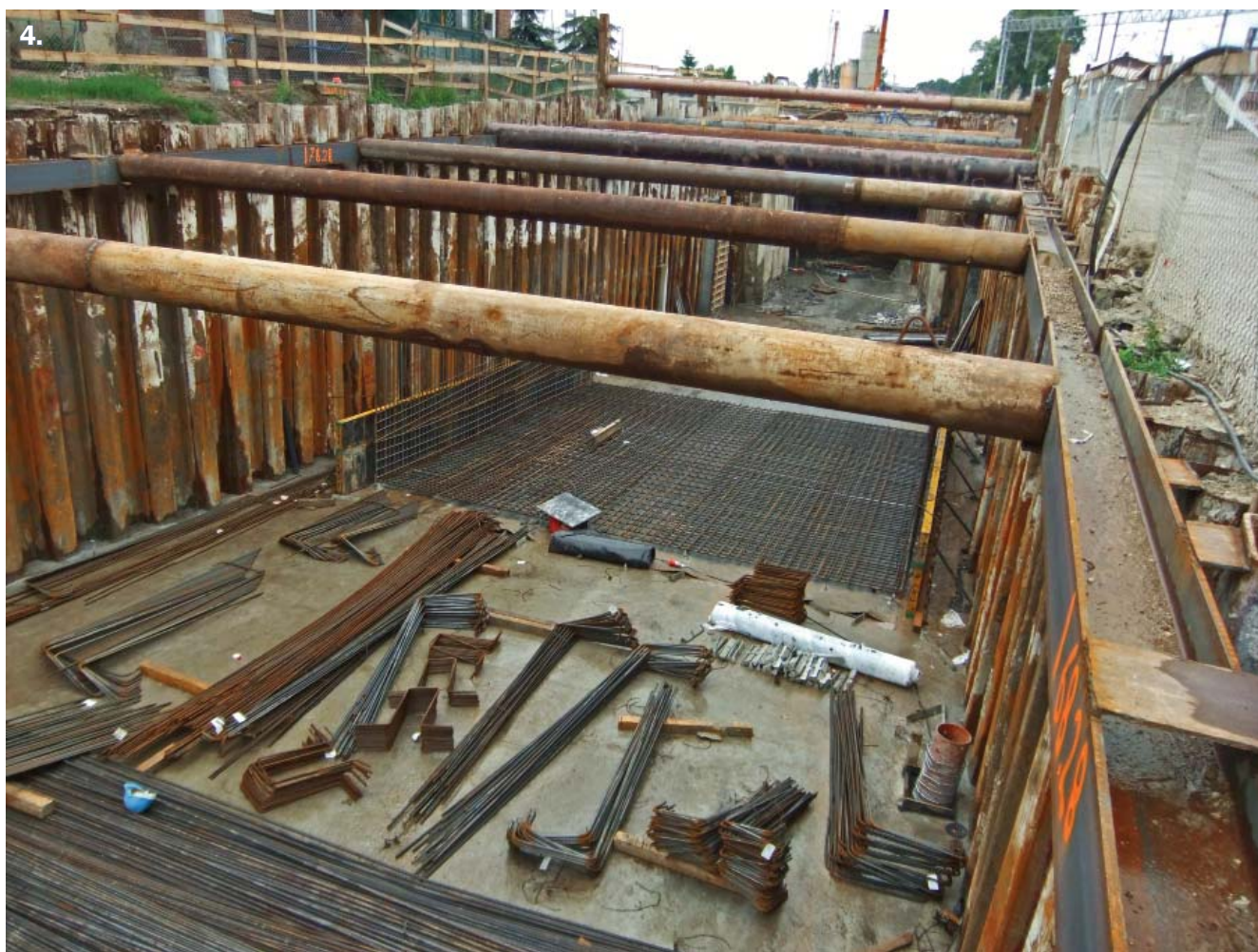
Fot. 3. Wiertnice w trakcie prowadzenia robót w bezpośrednim sąsiedztwie torów Fot. 4. Zbrojenie płyty dennej
