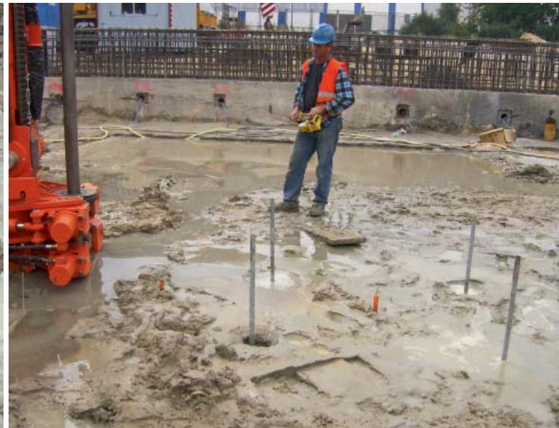
Fot. 4b. | Wykonawstwo próbnych kolumn jet-grouting
