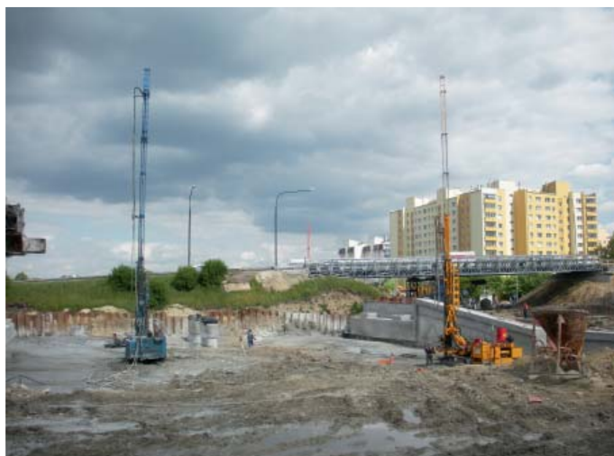
Fot. 5a. | Wiertnica Klemm (po lewej) i Atlas Copco (po prawej), w tle tymczasowy wiadukt Powstańców Śląskich
