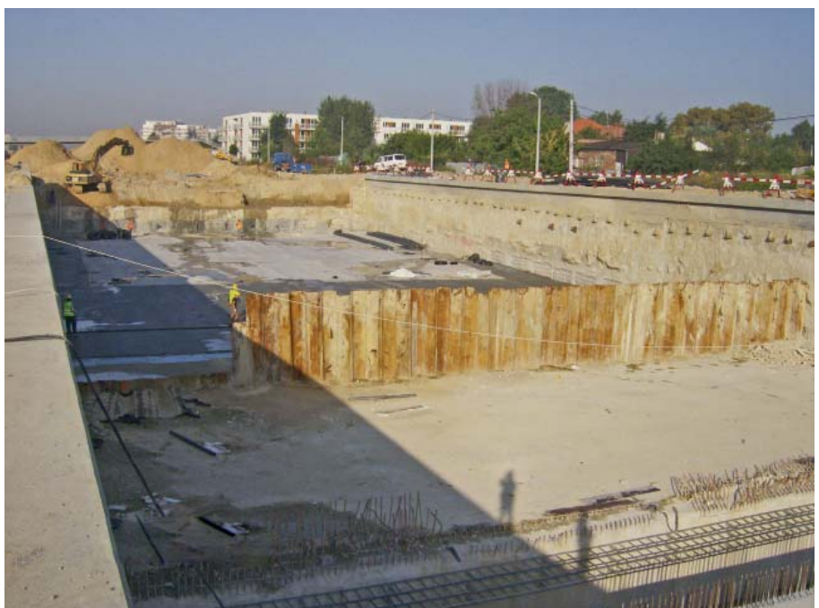
Fot. 3. | Technologiczne przegrody pionowe – podział na sekcje
