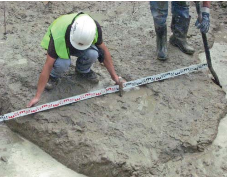
Fot. 4a. | Pomiar średnicy kolumny ok. 2 m
