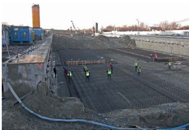
Fot. 2a. | Roboty zbrojarskie – wykonanie poziomej płyty żelbetowej
