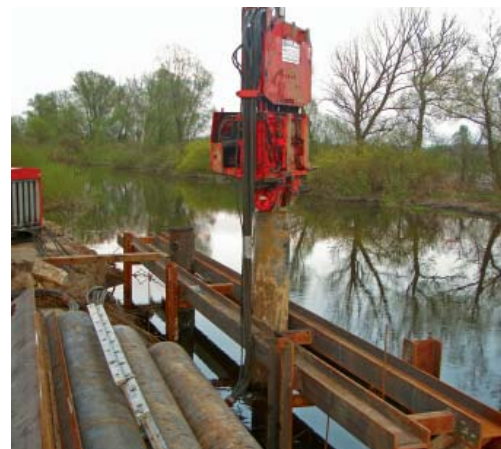
Fot. 3. | Konstrukcja prowadząca z kształtowników stalowych
