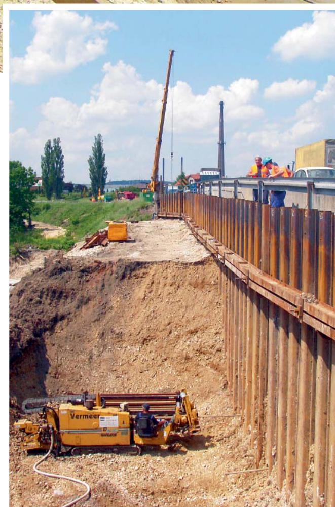
Fot. 2. | Wiertnica Vermeer D16x20 podczas montażu ściągów metodą HDD
