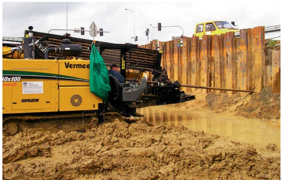
Fot. 4. | Montaż ściągnięć metodą HDD na Węzle Sośnica (2008 r.)
