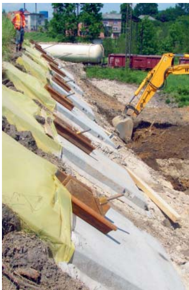
Fot. 3. | Bloki kotwiące na płytach drogowych
