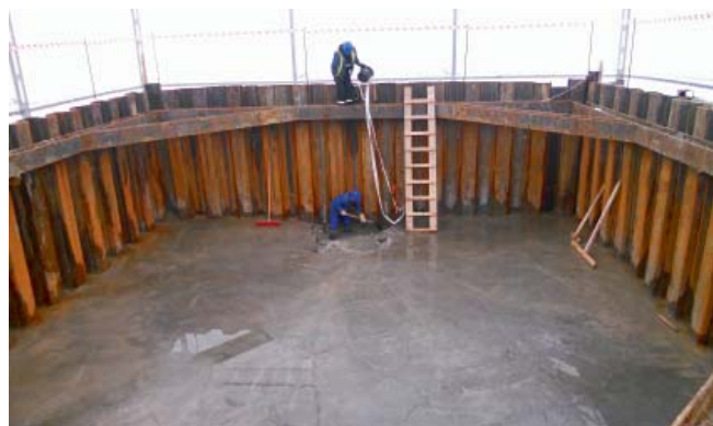
Fot. 3. | Wykonywanie fundamentu w ściankach z grodzic stalowych
