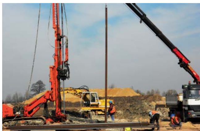
Fot. 1. | Urządzenie MDT w trakcie formowania pali
