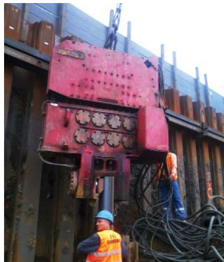
Fot. 5. | Pograżanie grodzic stanowiących zabezpieczenie podpór prostopadłych do osi toru
