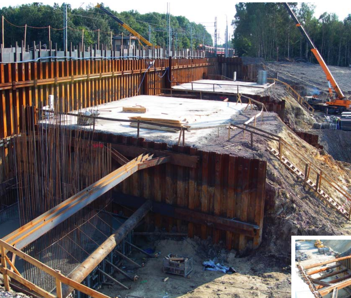
Fot. 1. | Widok na wykonane zabezpieczenie wykopu – drugi rząd ram stalowych w osi A
