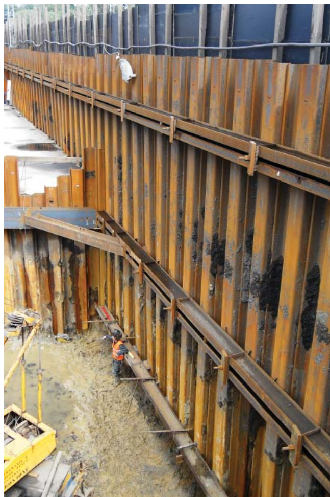
Fot. 8. | Montaż ram stalowych trzeciego rzędu
